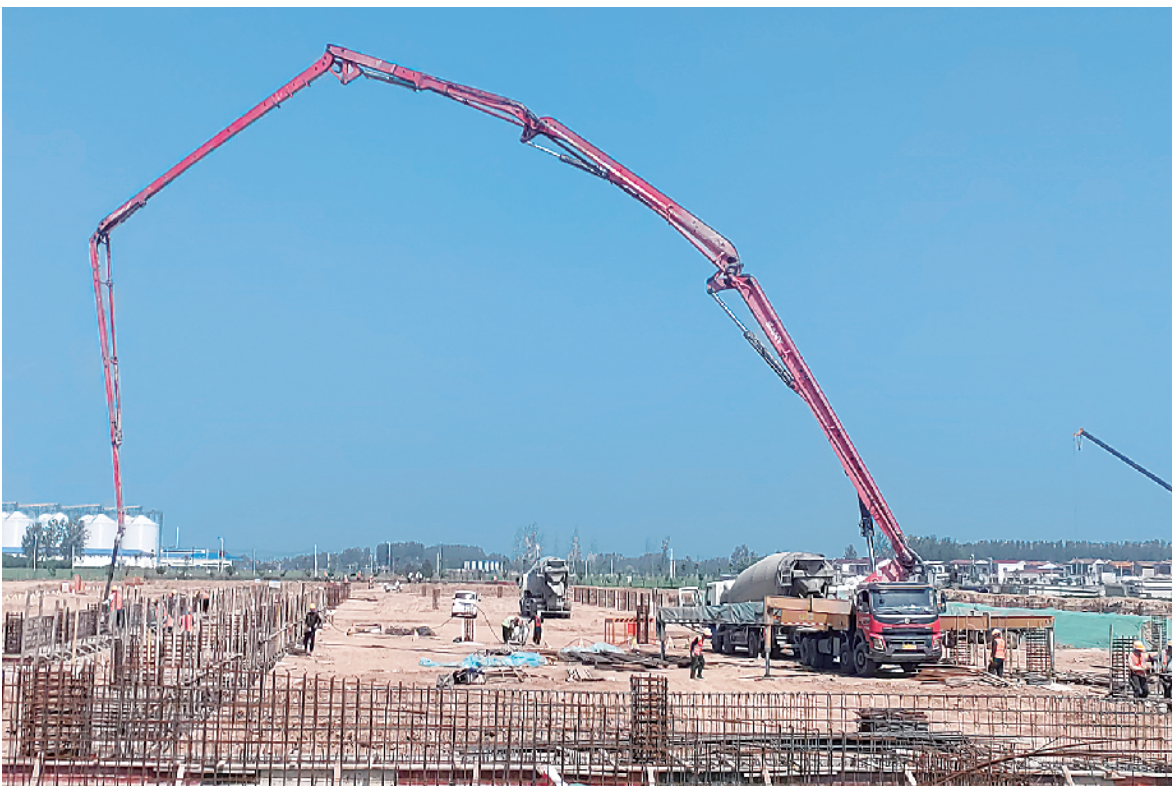
施工中的周口港中心作业区。
