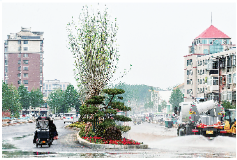
4 月 11 日上午，周口中心城区文昌大道西延工程主道路全线建成通车，施工人员正在建设辅道和道路附属设施。作为我市重点工程，文昌大道西延工程东起中州大道，西至汉阳路，横跨贾鲁河，全长 970 米，采用双向六车道设计。
