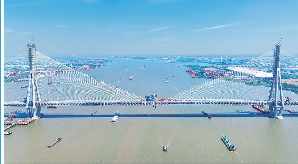
5月29日拍摄的常泰长江大桥主航道桥合龙段钢桁梁吊装现场(无人机照片)。
